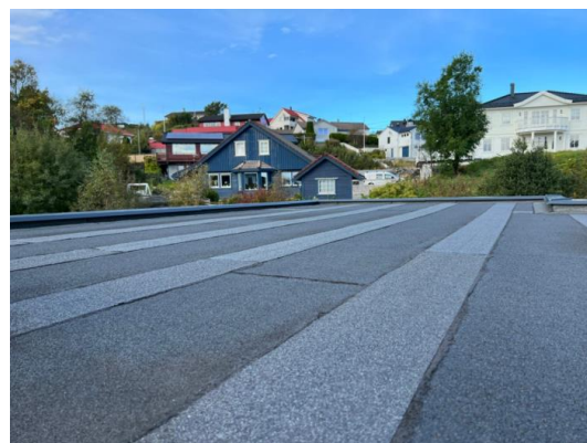
Taktekking observert fra stige.
